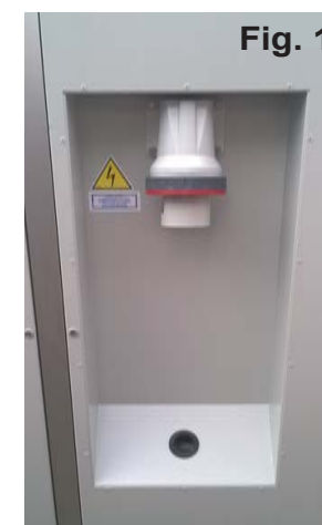
Fig. 1 Prise CEE 63 A, 5 pôles, 400 V
